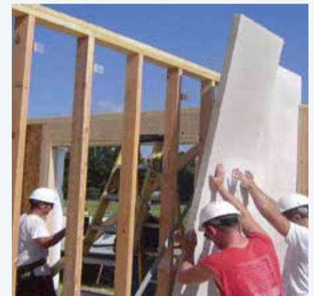
Панели для заполнения каркасных конструкций – одна из основных сфер применения газобетона в Америке
