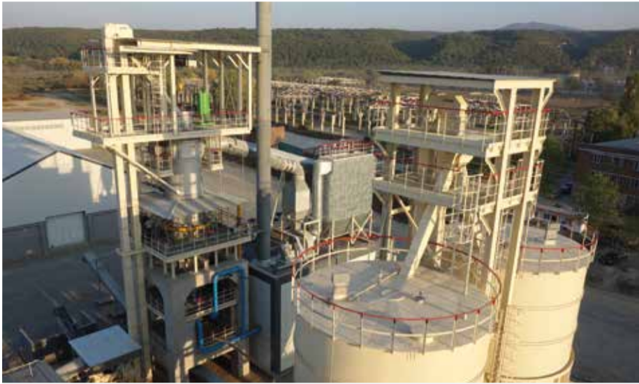
Завод по производству извести первым введен в эксплуатацию
