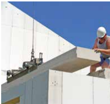
Panneaux de BCA renforcés en tant qu'éléments porteurs de mur et de toiture
