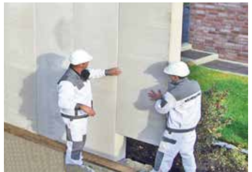
Panneaux muraux appliqués verticalement peuvent être installés rapidement et facilement
