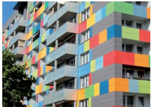
纤维水泥外墙可经受最恶劣的气候条件。
