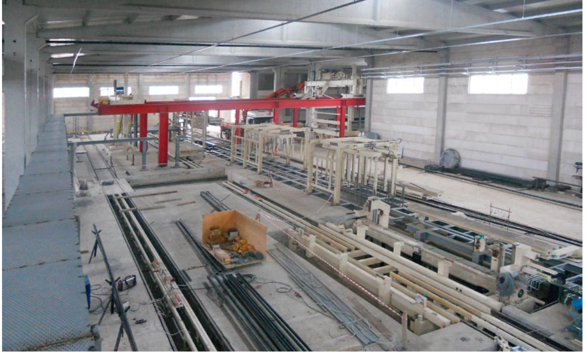
Abb. 1 Die im Aufbau befindliche Anlage - die größte Porenbetonanlage der Welt steht in der Türkei.
